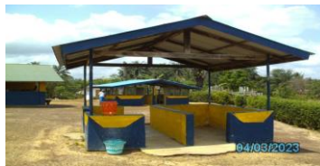
Die umzubauenden Clinic-Gebäude in Mawah
