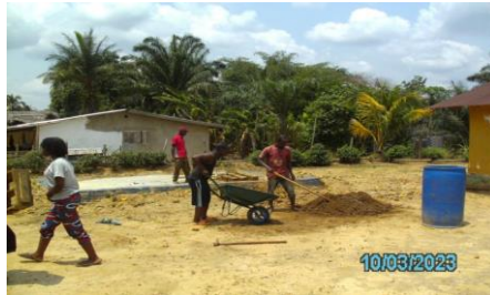
Die Clinic-Mitarbeiter beim Herstellen von sogen. „dirt bricks“
